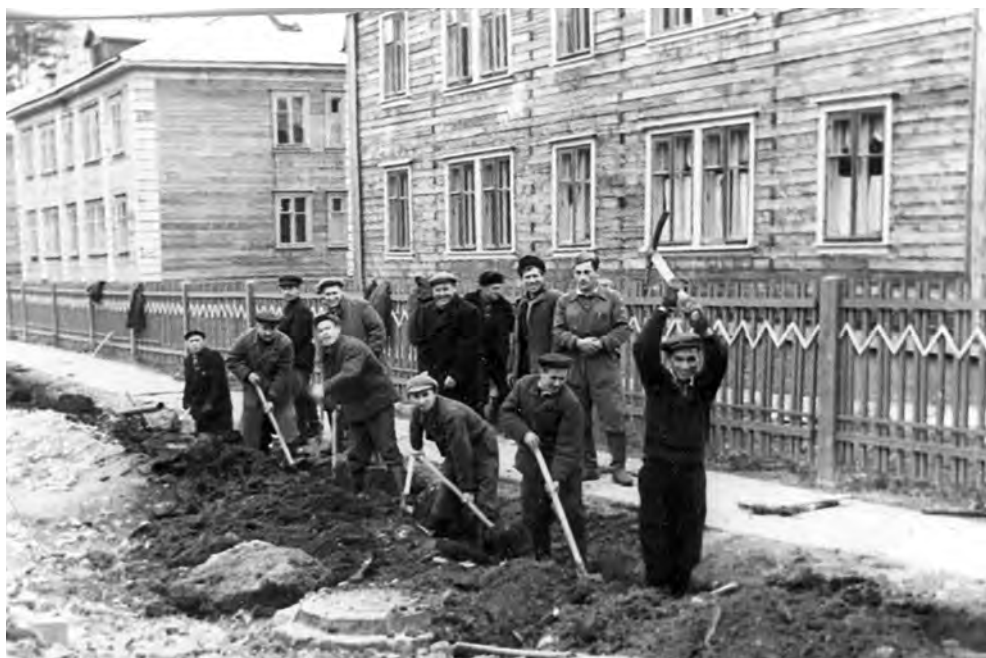
На строительстве г. Снежинска
