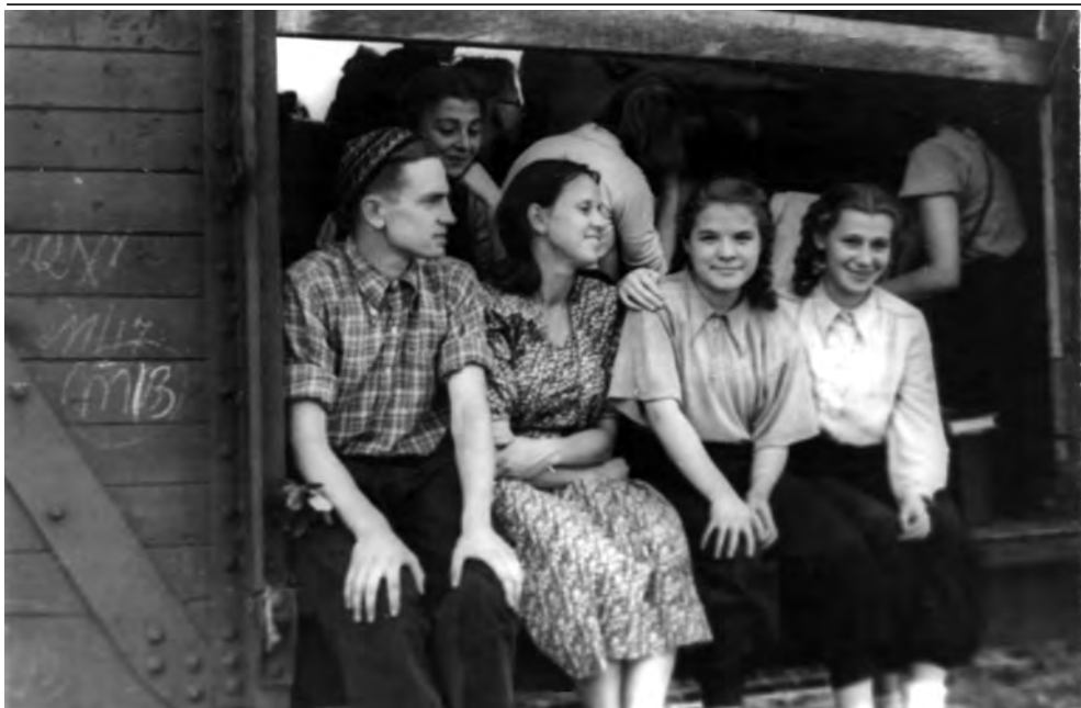
Студенческая межколхозная стройка ГЭС
