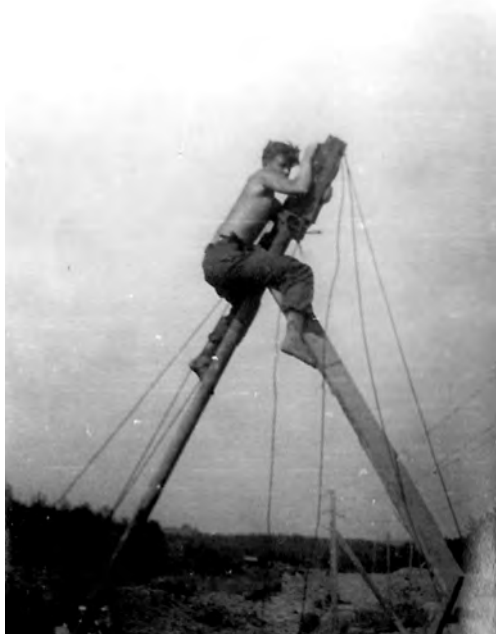
Студенческая межколхозная стройка ГЭС
